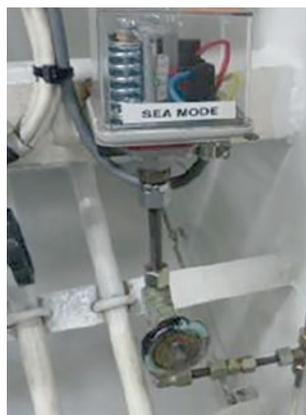
Mit dem T-Anschluss werden die Druckluftleitung geöffnet und die zusätzlichen Druckschalter installiert. Die Auswahl zwischen See-Modus und Manöver-Modus erfolgt durch einen weiteren Schalter an der Schalttafel. Für jeden Hauptkompressor ist ein zusätzlicher Druckschalter nötig.
